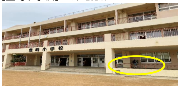
【豊崎小学校】公衆電話前のスロープ
