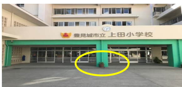
【上田小学校】玄関前の柱（中央）
